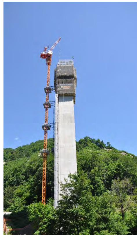
P 2 橋脚全景
