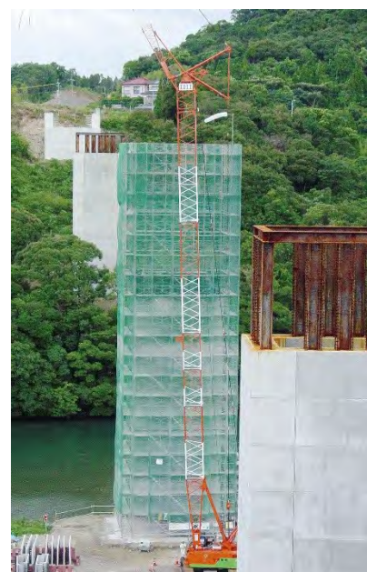
施工状況（P1～P3）
