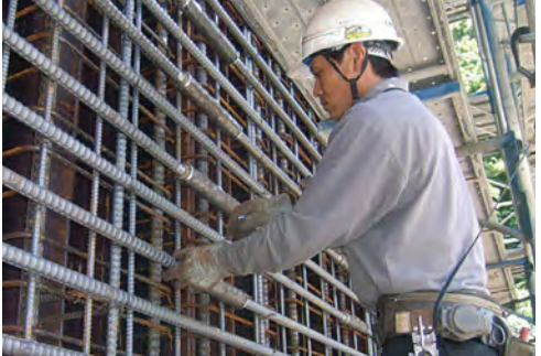
帯鉄筋組立て
