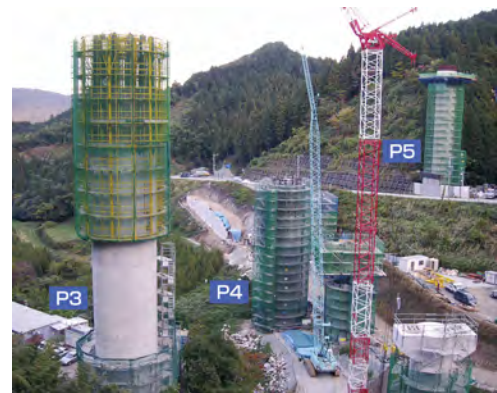
施工状況 (P 3 ~ P 5)
