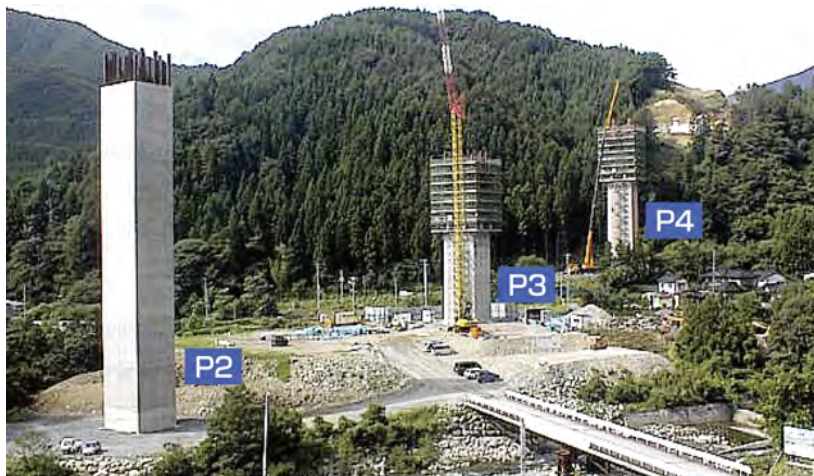
工事全景 (P2～P4)
