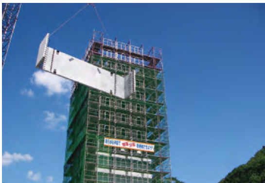
3 H パネル吊込み
