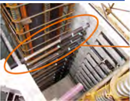
3 H パネル継ぎ手状況
