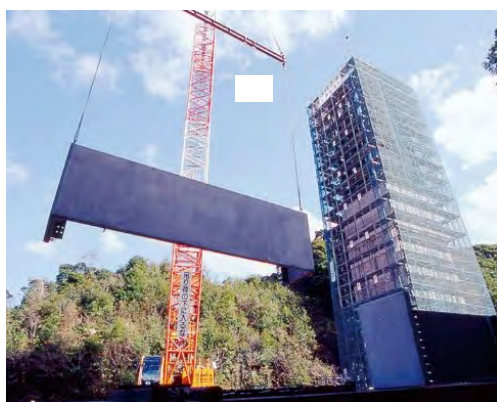
3 H パネル建て込み
