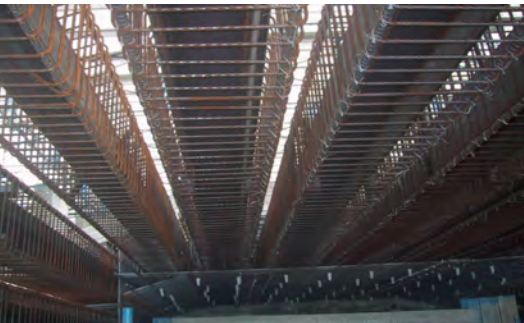
スパイラルカラムの建込・接合完了
