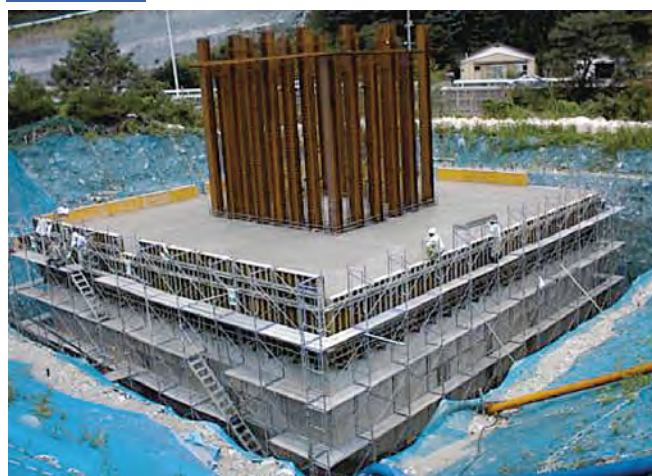
スパイラルコラム第1ロッド建込み・コンクリート打込み完了
