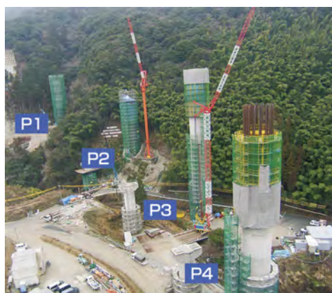
施工状況 (P 1 ~ P 4)
