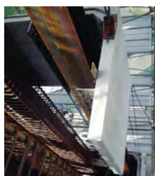
3 H パネル吊込み
