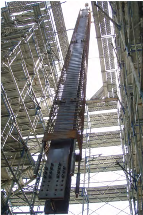
スパイラルカラム建込み
