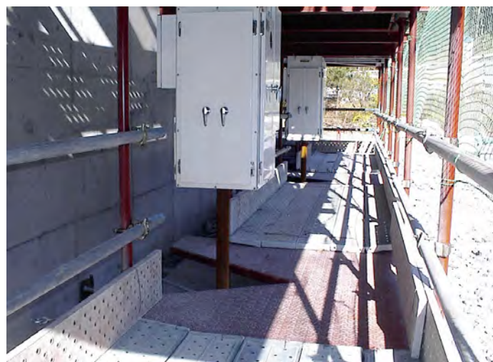
昇降式作業足場
