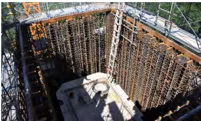
スパイラルカラム建込み完了
