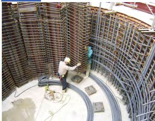
深礎杭基礎へのスパイラルカラム定着
