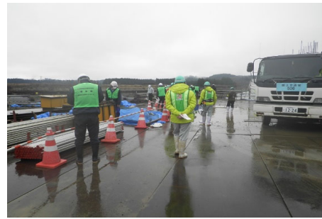
B班 川崎排水樋門巡視
