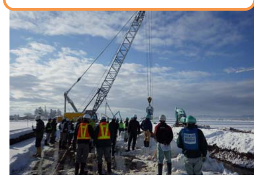
横手西部農業水利事業 油川幹線排水路(その17)工事
