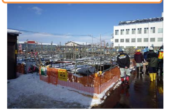
横手警察署建築工事 H29-YPS-A
